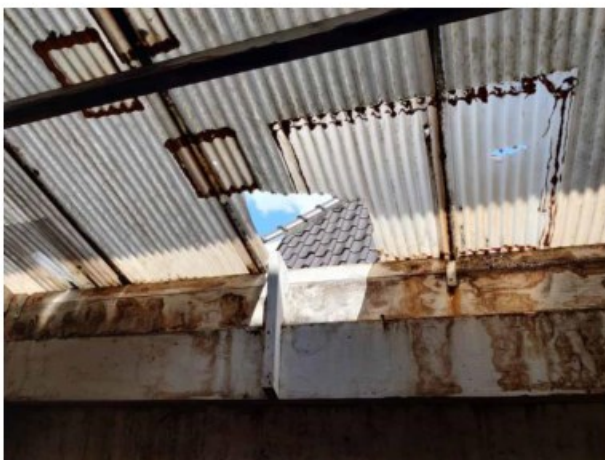
Figuur 11 Zwarte golfplaten op het oosten van het pand
