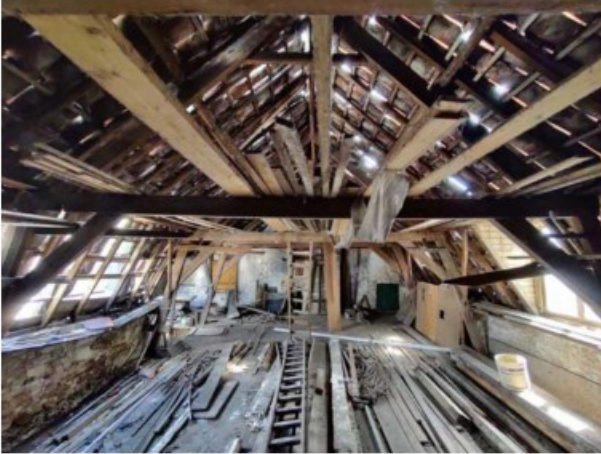
Figuur 13 Zolder van het pand
