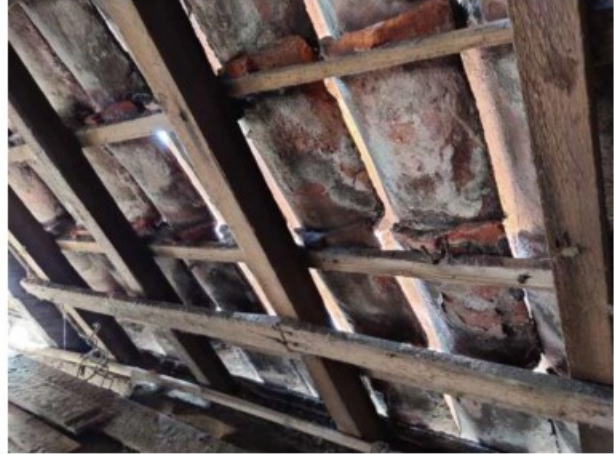
Figuur 14 Binnenzijde van de dakpannen met daarachter direct de open ruimte van de zolder
