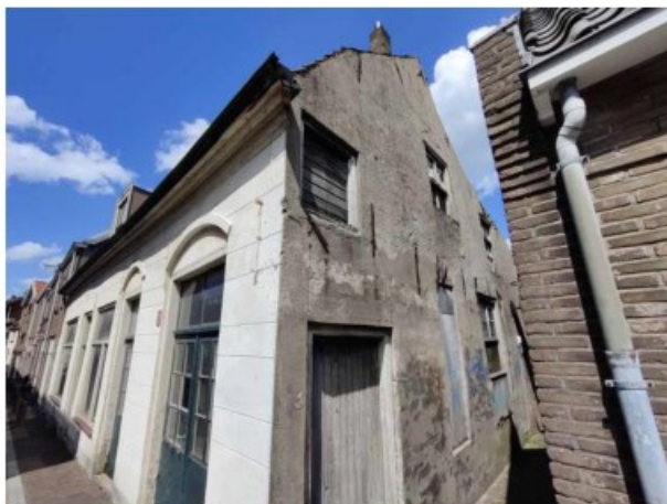
Figuur 3 Zijaanzicht van het pand vanuit zuiden gezien
