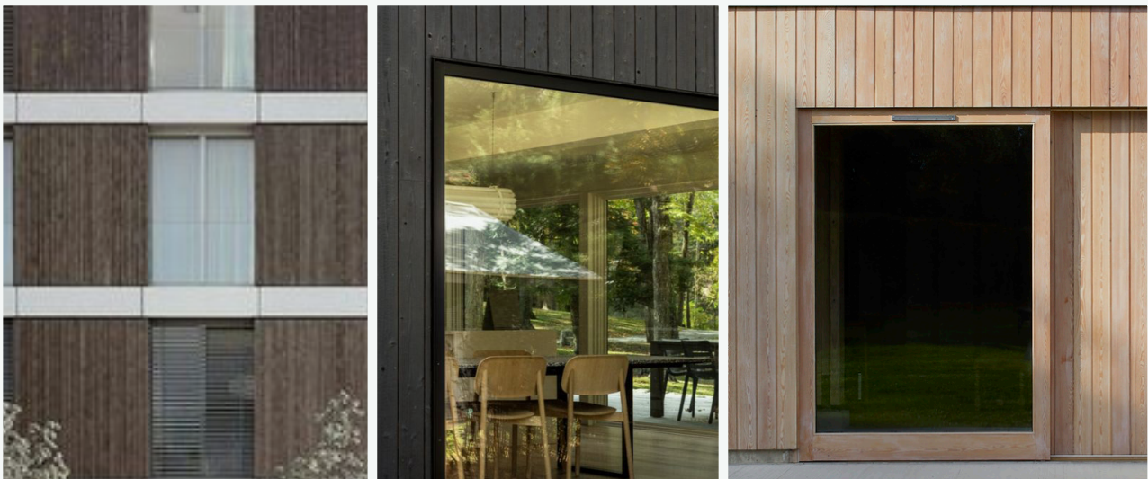
WONINGEN ZULLEN WORDEN UITGEVOERD MET DUURZAME KOZIJNEN.
