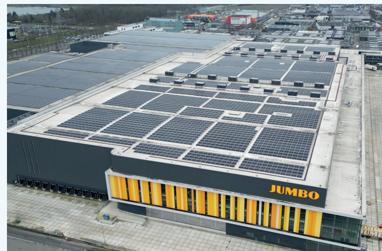
^ Opwek op dak van distributiecentrum Jumbo Nieuwegein
