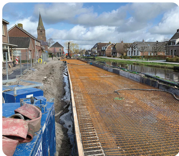
Afbeelding 1 - De wapening is aangebracht op de Mijzijde.
