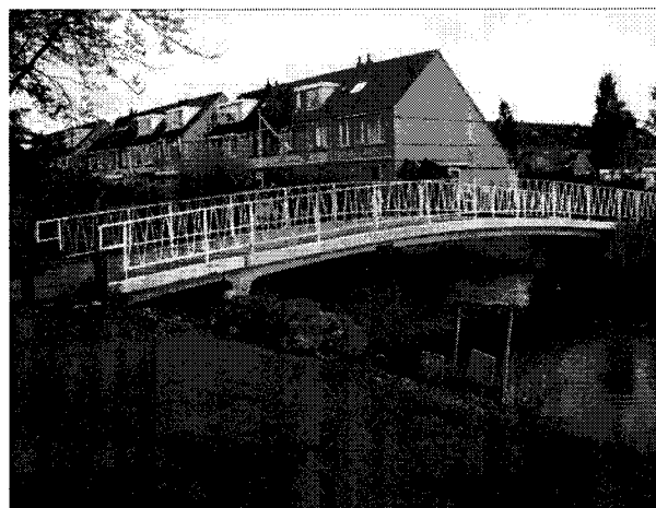
Valckslootlaanbrug, Hillegom (gemeentelijk) Bouwjaar 1971 Betonnen liggers, overspanningen 11,5 m. en 2 x 2,5 m.
