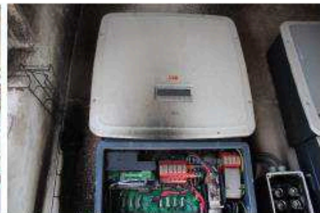
De kap van de linker omvormer verwijderd
