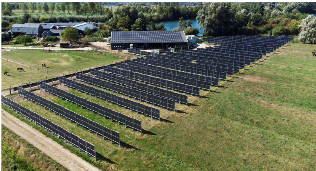
Pilotproject met verticale zonnepanelen in Culemborg. Bron: William Hoogteyling
