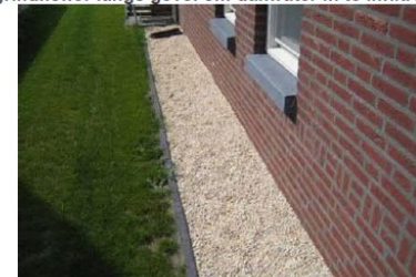
grindkoffer langs gevel om dakwater in te infiltreren
