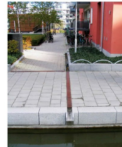
grindkoffer langs gevel om dakwater in te infiltreren
