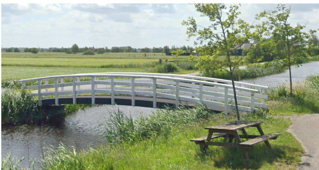
Brug ter hoogte van Mijzijde nr. 154
