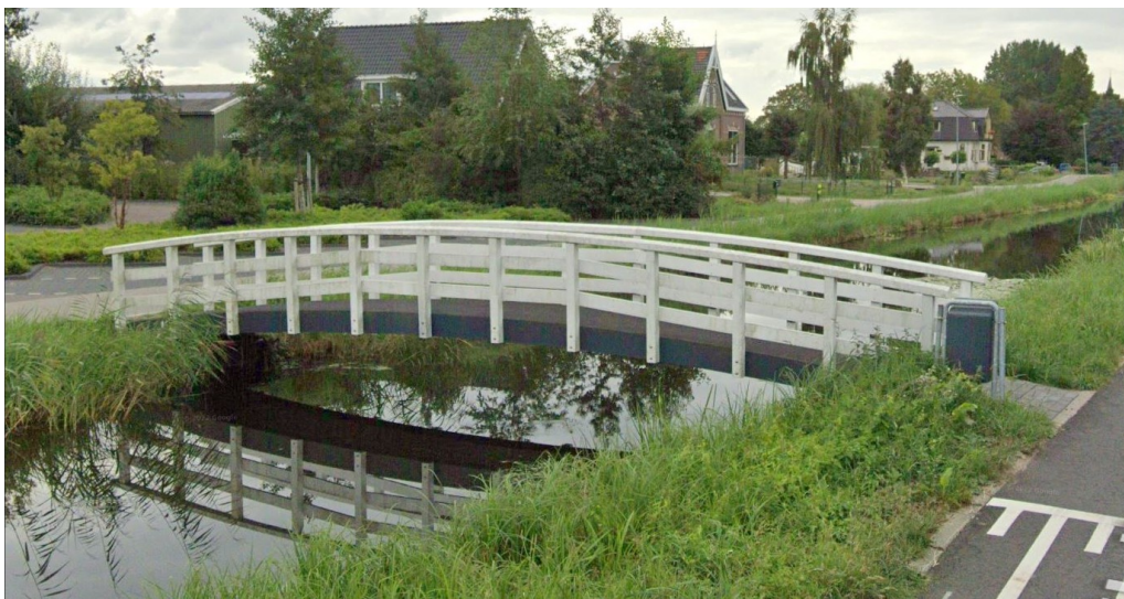
Brug ter hoogte van Mijzijde nr. 88
