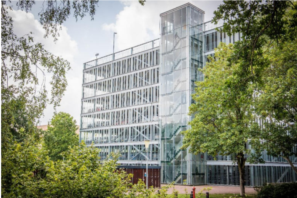
Afbeelding 5.1 Open parkeergarage (bron: Tom Hessels, IFV)
