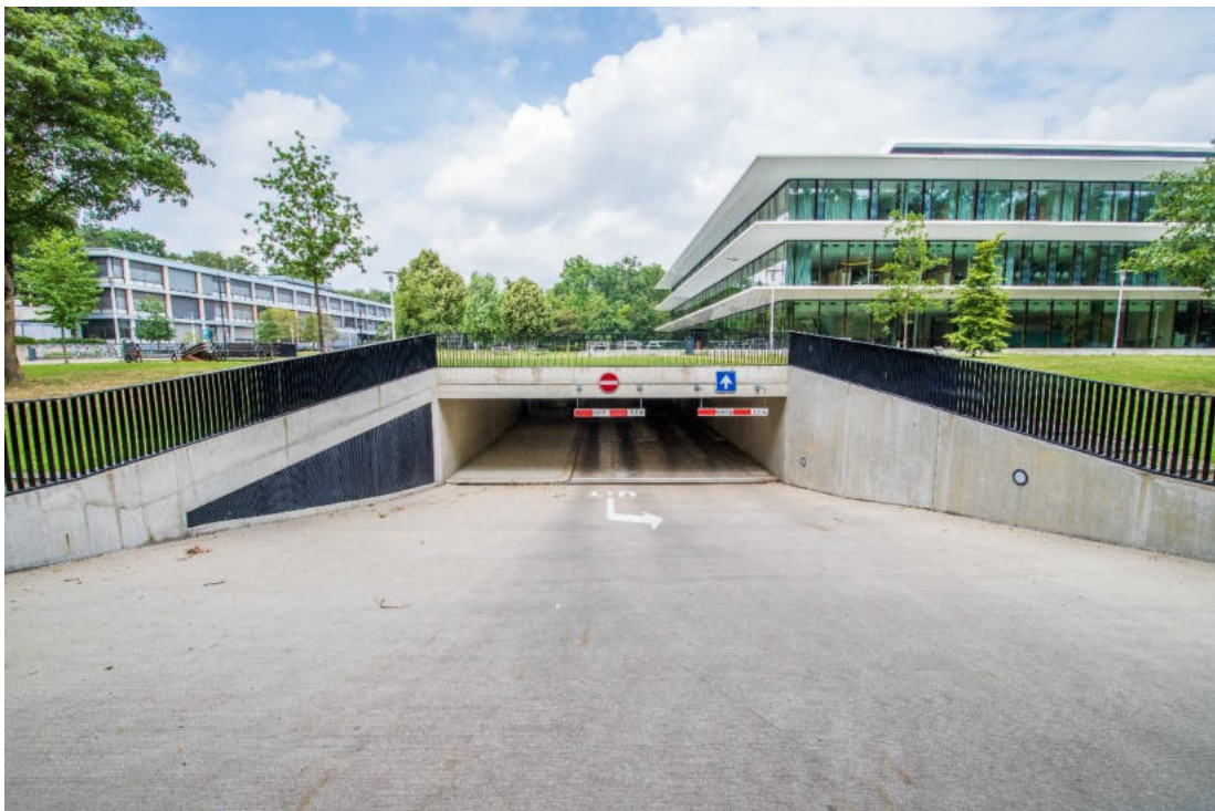
Afbeelding 5.4 Ondergrondse parkeergarage (bron: Tom Hessels, IFV)
