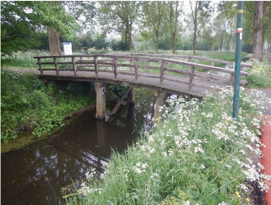
Figuur 1: Brug 10-007, Waardsedijk
