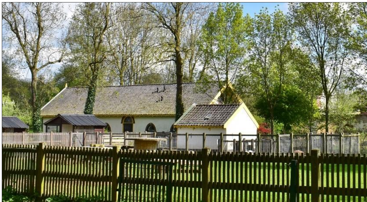
Ten westen van het hoofdgebouw staat een klein rechthoekig schuurtje met een pannen zadeldak.
