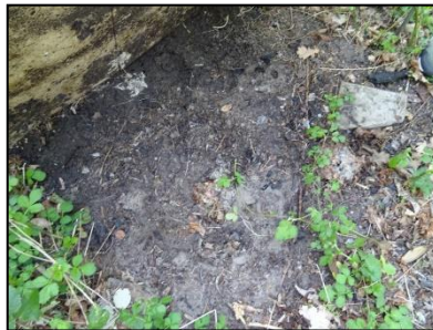
Figuur 13. Muizennesten onder de houten plaat.
