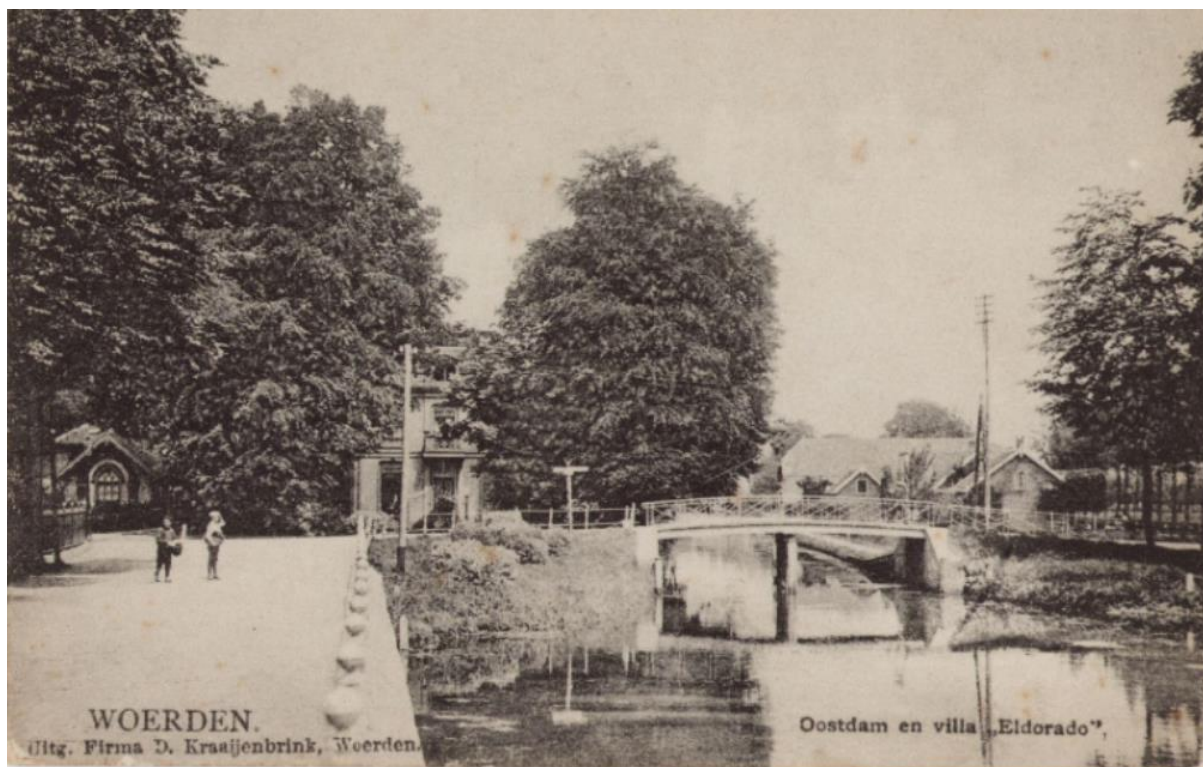
De Snellerbrug, gezien vanaf de Oostdam. Prentbriefkaart van kort na 1905. Geheel links staat de voormalige koetsierswoning annex koetshuis van het landgoed van de familie Bredius. In het midden de villa Eldorado uit 1842. Rechts de Utrechtsestraatweg. De hier afgebeelde brug is in 1927 vervangen door een nieuwe 7 . De huidige brug is in 1985 aangelegd. Het koetshuis is afgebroken toen de Oudelandseweg in 1975 werd verbreed.
