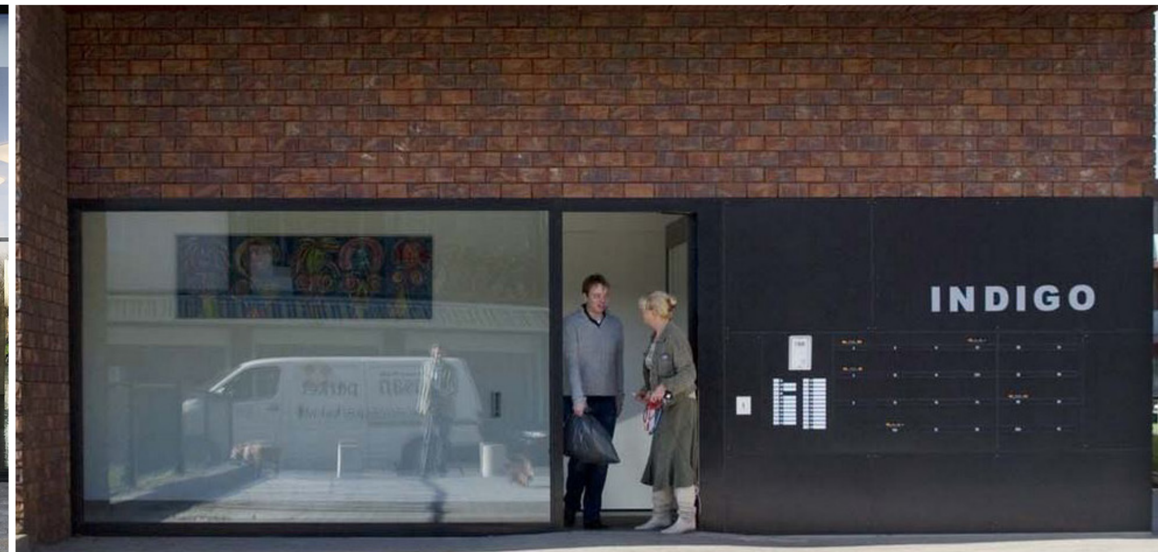
Postkasten in het gevelvlak
