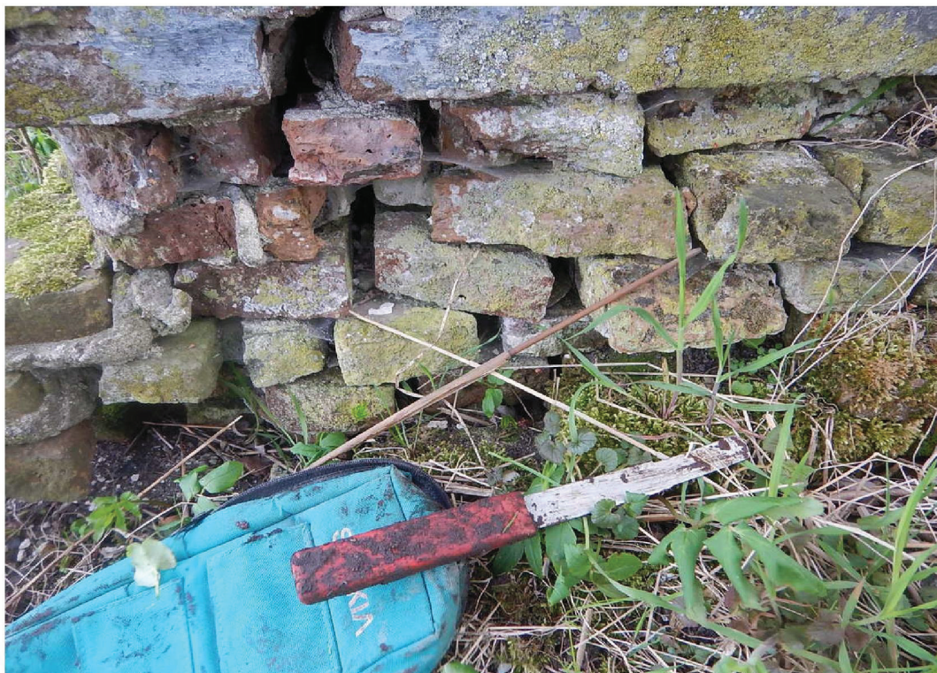
Figuur 5: Foto van de onderzijde van de bouwmuur aan de voorzijde van de boerderij.
