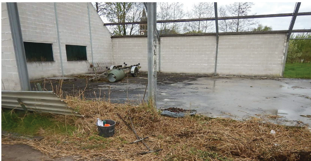
Figuur 7: Betonvloer bij niet afgebouwd pand.
