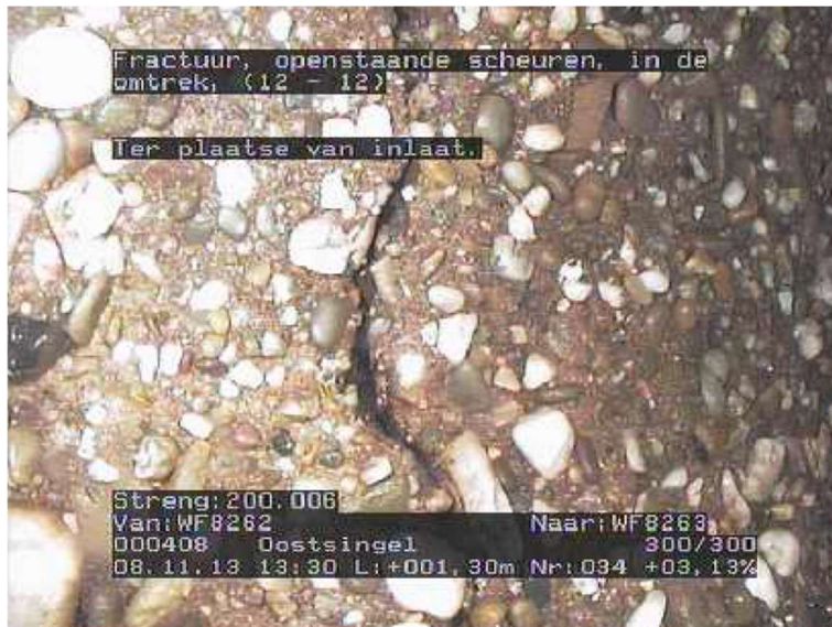
Openstaande scheur en biochemische aantasting
