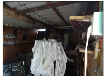
Figuur 14. Binnenkant schuurtje met openingen, gelegen achter de woning.
