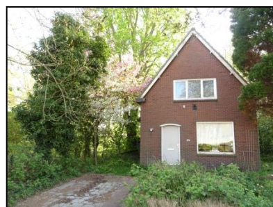
Figuur 5. Overzichtsfoto voorkant van de te slopen woning.
