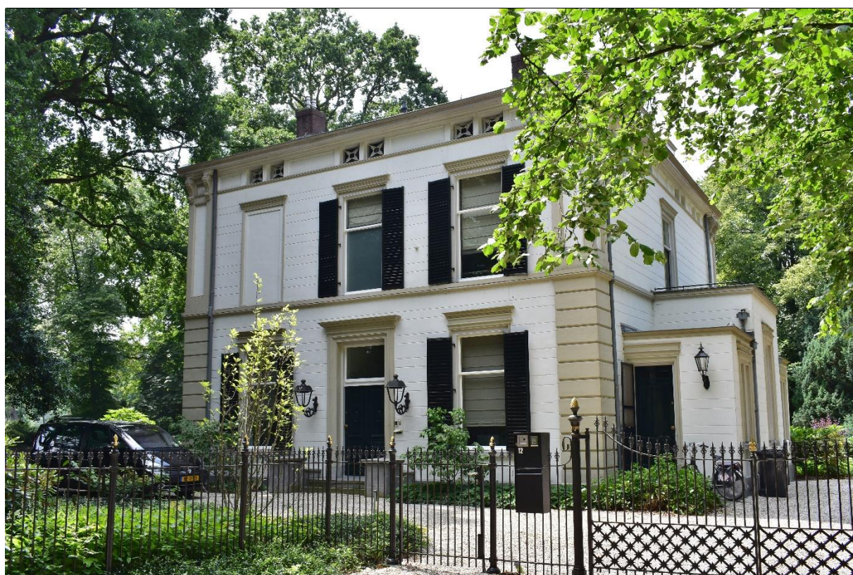
Huis Rijnoord, voorgevel.
