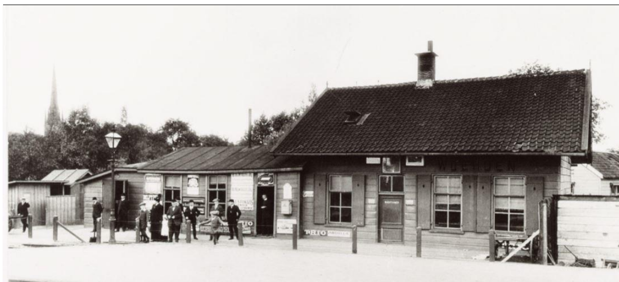
De oude houten stationsgebouwen die tot 1913 hebben gefunctioneerd op een uit het zuiden genomen foto uit ca 1900 5 .
