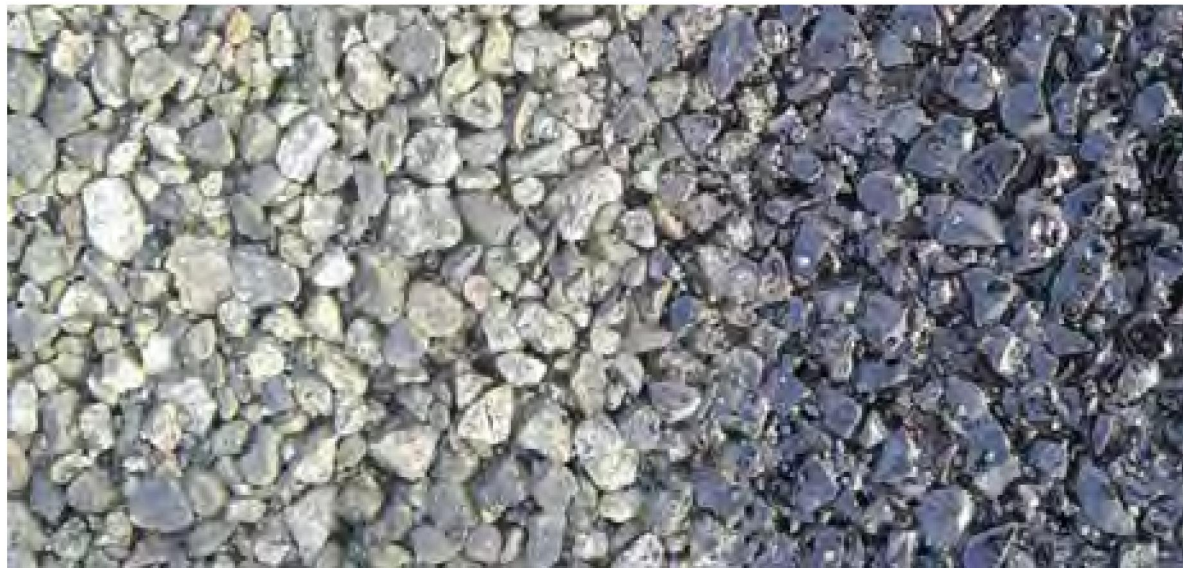
Asfalt met een dikke ingewalste splitlaag
