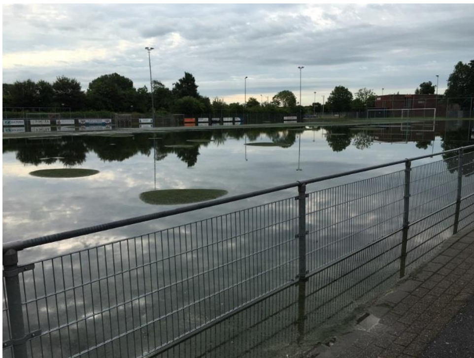
Een beeld van veld 6 bij hevige regenval met opbolling van de mat door luchtinsluiting.
