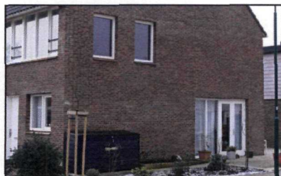
kopgevel zorgvuldig vormgegeven
