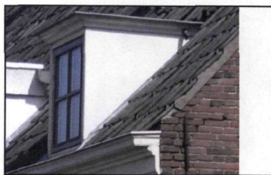
overwegend doorlopende goot
