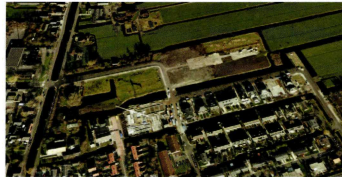
Nieuwbouwactiviteiten aan de noordrand van Kamerik. Een duidelijke waterstructuur omringt de nieuwbouw, ruimte voor landschappelijke inpassing lijkt niet aanwezig.
