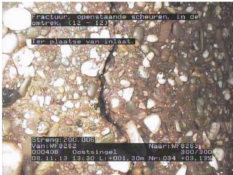
Openstaande scheur en biochemische aantasting
