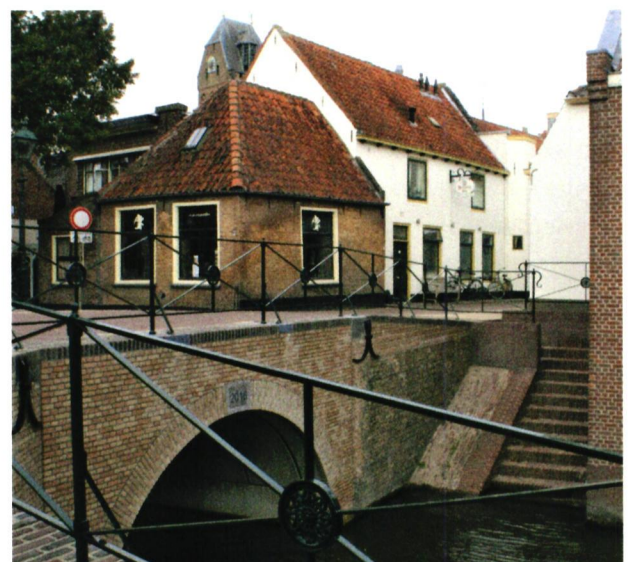
Oudewater: Romeijnsbrug vernieuwd als boogbrug.
