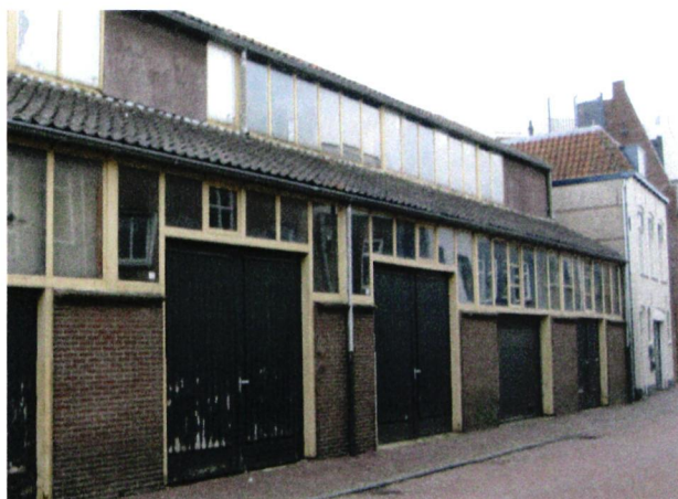
Voor dit bijzondere bedrijfsgebouw heeft de werkgroep de monumentenstatus aangevraagd.
