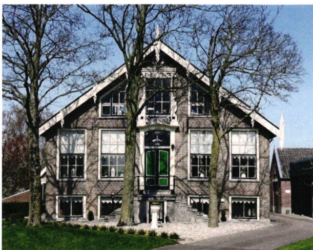
Hoeve Knodsenburg bij Nieuwerbrug met in 17e eeuw afgeschuind dak.
