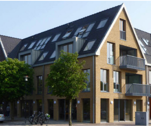
Het volume is eenduidig met karakteristieke kap
