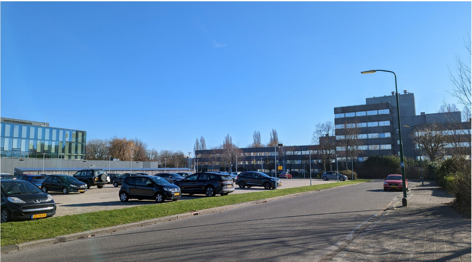
naastgelegen voormalig campina gebouw
