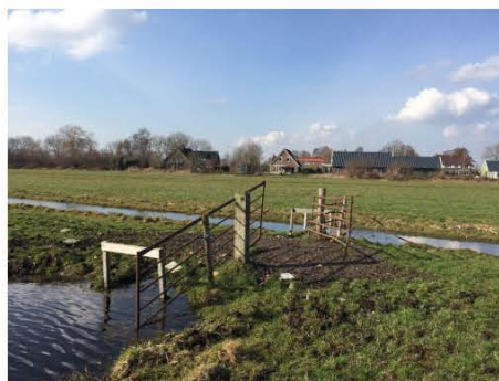
meetpunt Dam 8 (puindam) met duikers 8491196
