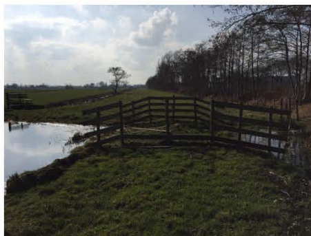
meetpunt Dam 5 met plastic damwand 8491184
