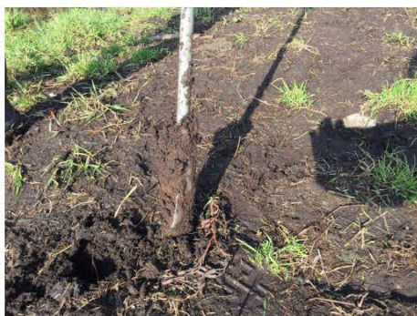
meetpunt Dam 5 met plastic damwand 8491186
