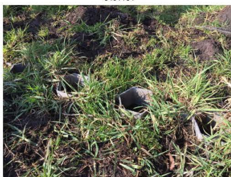
meetpunt Dam 5 met plastic damwand 8491185
