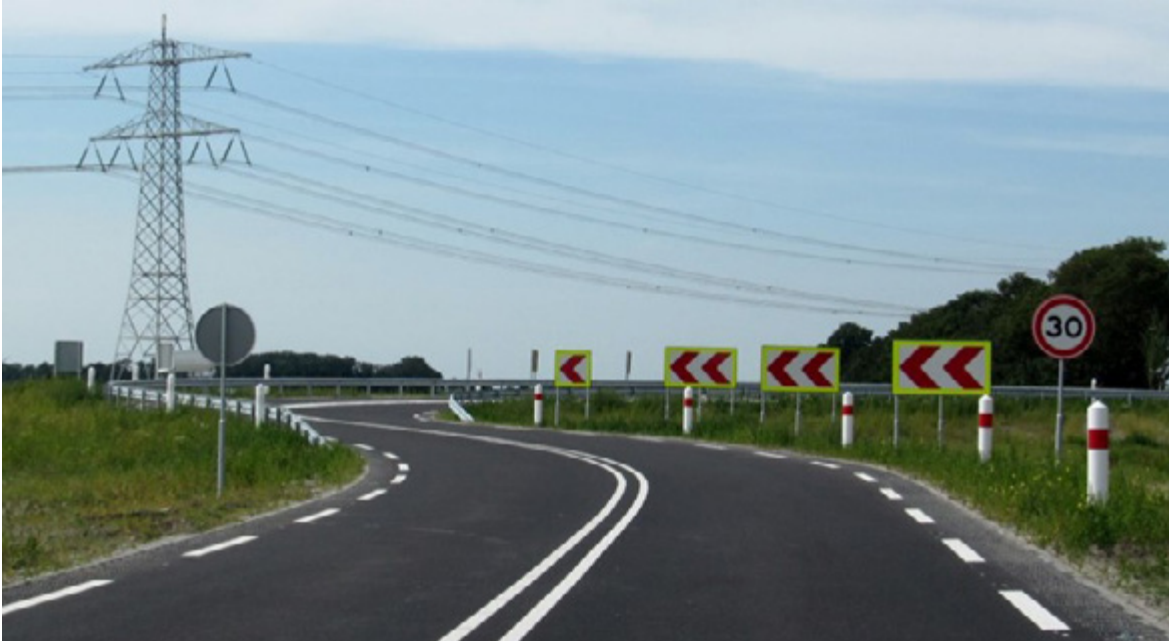
Afbeelding 22: Schildbochten in combinatie met balises, snelheidsborden en een duidelijke belijning waardoor er geen verlichting aan de pas hoeft te komen. Bron: wegenwiki.nl
