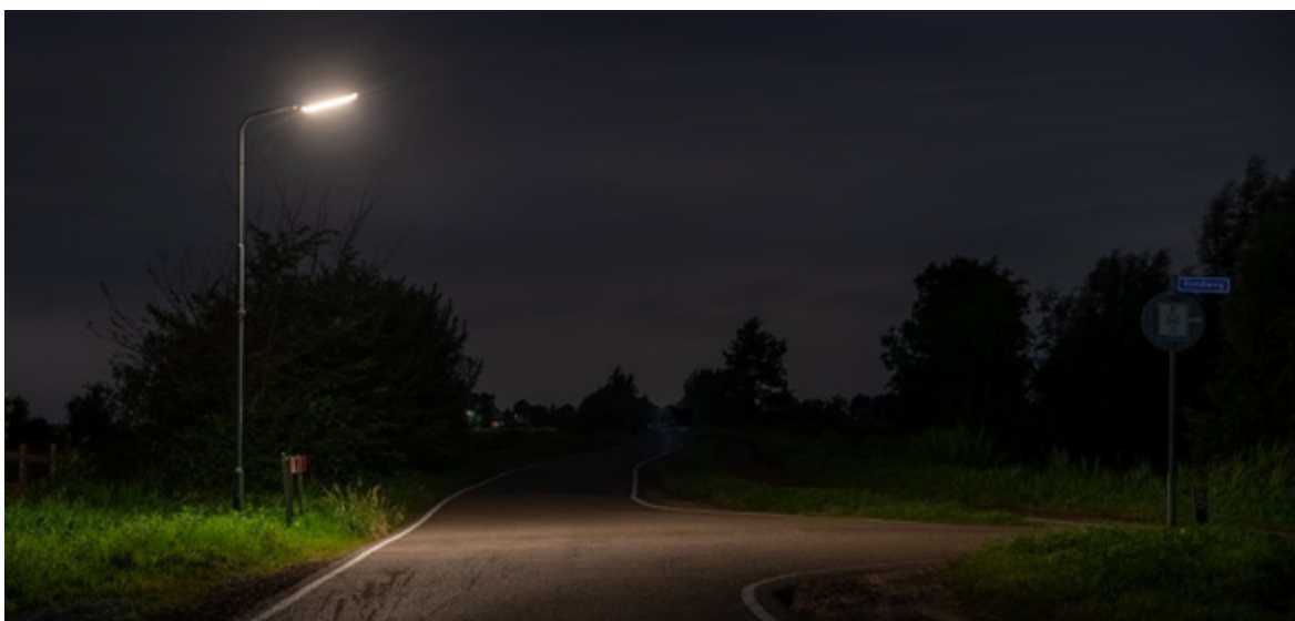
Afbeelding 9: Lichtmast in buitengebied bij Zegveld. Merk op dat het kruispunt wel verlicht is en de rest van de omgeving niet. Bron: Joeri Kemp Fotografie
