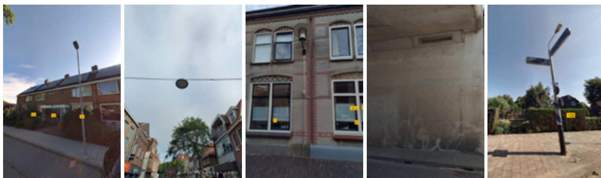
Afbeelding 14: Voorbeelden van functionele openbare verlichting in gemeente Woerden. Van links naar rechts: straatverlichting, overspanningsverlichting, wandarmatuur, tunnelverlichting, en een ANWB mast.
